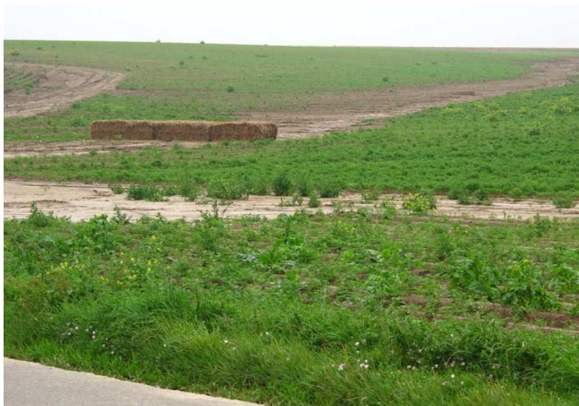
Photo 4 - Déviation d'urgence d'un axe d'écoulement par des ballots de paille de grand format
