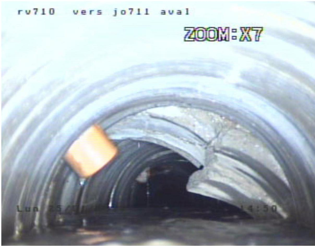
Figure 5. Effondrement de conduite mis en évidence par une inspection visuelle par caméra de zoomage
