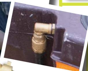
Étape 5 : couper la longueur de socarex nécessaire pour créer un appel suffisant pour vidanger le bac et la vase accumulée. Fixer une extrémité au té et la vanne à l'autre extrémité, à l'aide de la 2ème tétine
