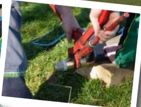
Étape 4 : couper la longueur de socarex nécessaire pour atteindre la zone d'alimentation à une distance maximale du bac de 200m, pour limiter les pertes de charge. Fixer une extrémité au té et la crépine à l'autre extrémité, à l'aide du raccord HUOT préalablement étanchéifié avec du téflon
